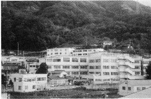
呉みどりヶ丘病院全景
